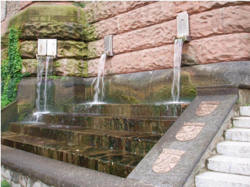
Abb. 1: Über die Wasserspiele an der Außenwand der Turmbastion wird das in die Station geförderte Rheinwasser zurück in den Fluss geleitet. In Stein gemeißelt: die Wappen der drei kooperierenden Bundesländer.
